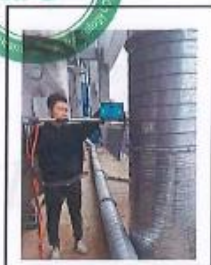
开料、木加工、钻孔 工序废气排放口 G1
