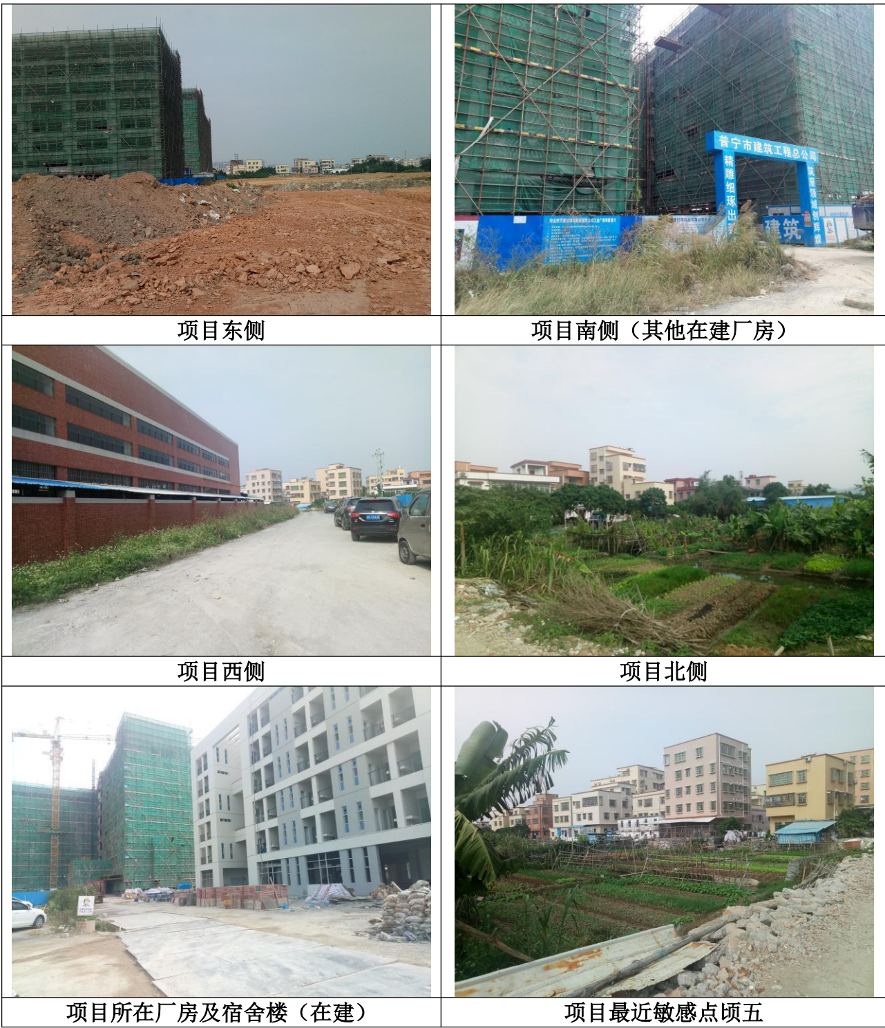
附图十八 项目现状及项目四周照片
