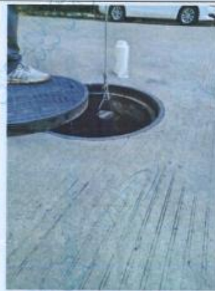
W1 生活污水排放口
