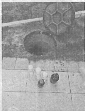
生活污水排放口
