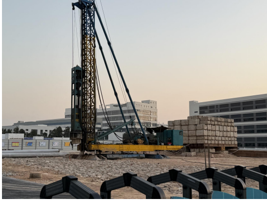
工程建设区现状
