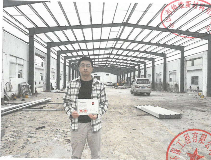
工程师现场勘察照片
